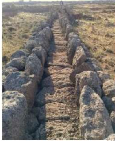
(الصورة 11) قناة جر المياه
