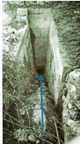
(الصورة 18) مسرى الشغال المائل
