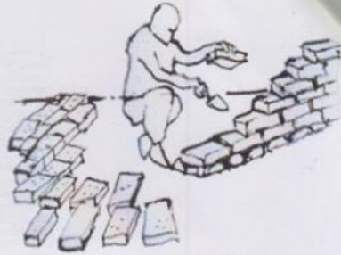
الشكل ١١: رصف الجدار وإغلاق الفواصل.
