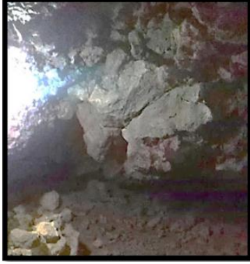
الصورة (52): كتل صخرية محاطة بالحجارة في سقف الحجره الثالثه.
