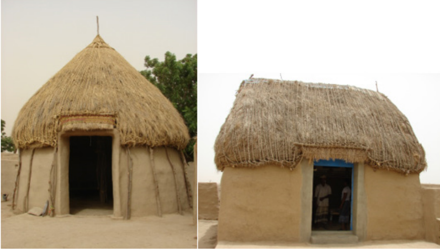
صورتان من تهامة: رقم (1) الكوخ ذو مسقط رباعي الزوايا وسقف جمل وني يسمى "عريش" ورقم (2) الكوخ دائري المسقط ذو سقف مخروطي يسمى "عُشَّة"، تصوير الباحث.
