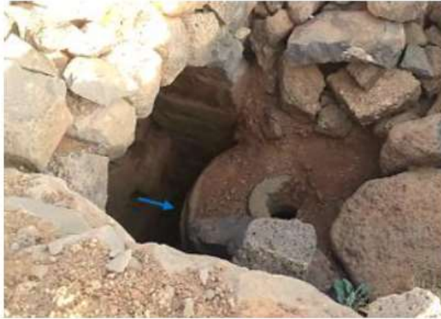
(الصورة 14) فتحة خروج الماء من أسفل البئر باتجاه الدوالب المائي الأفقي (عن مديرية آثار السويداء)
