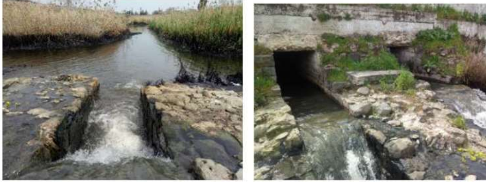
(الصورة 34) فتحات خروج الماء من الطاحون باتجاه مجرى النهر (عن تصوير عبد الهادي النجار)
