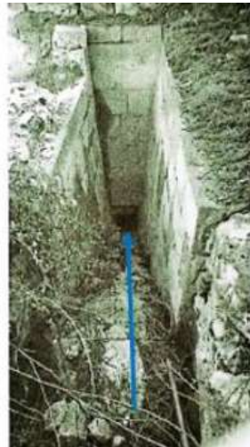
(الصورة 18) مسرى الشغال المائل
