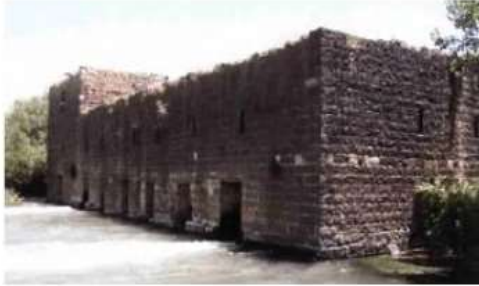
(الصورة 29) مبنى طاحونة أم رغيف في حمص (عن De Miranda, 2006, 299)
