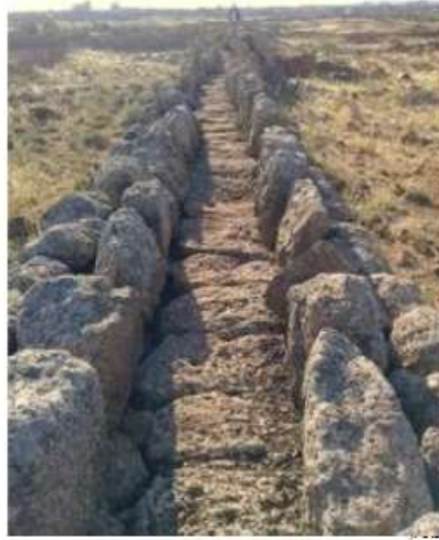
(الصورة 11) قناة جر المياه
