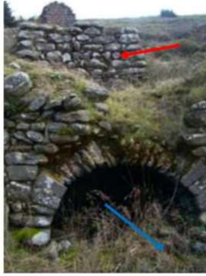
(الصورة 25) غرفة الطحن (عن سليمان، بعثة آثار مصياف)
