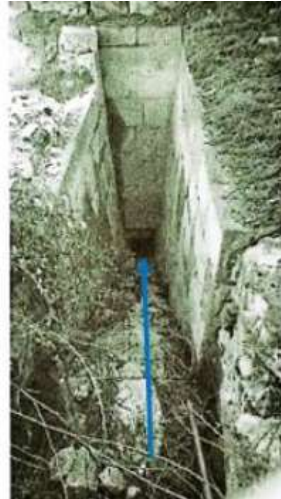
(الصورة 18) مسرى الشغال المائل
