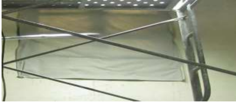
الشكل رقم (12) صورة توضح اغلاق النوافذ بقماش خاص لمنع أشعة الشمس المباشرة
