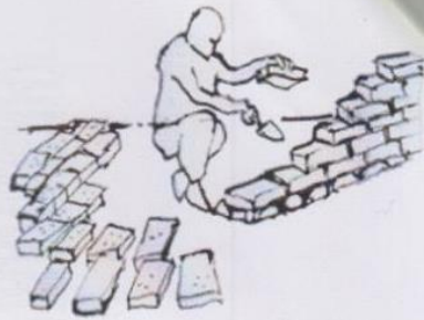
الشكل ١١ رصف الجدار وإغلاق الفواصل.
