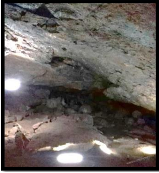
الصورة (41): انهيار كتلة ضخمة من السقف.
