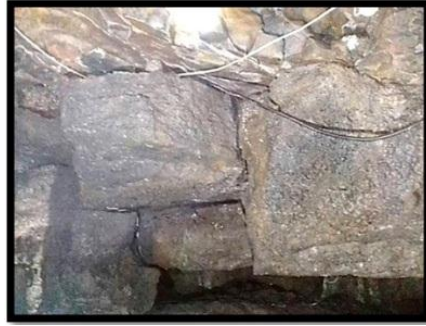
الصورة (13): كتل صخرية ملتصقة بسقف المدخل. الصورة (14): كتل صخرية في السقف عند نهاية الكهف تكشف بعد انهيار بطانته الداخلية.
