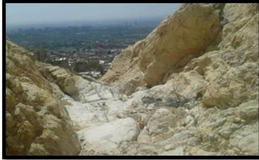
الصورة (29): موقع (2) مقترح لبناء الحاجز، عند بداية تضيق الوادي، وقبيل منطقة الركب.
